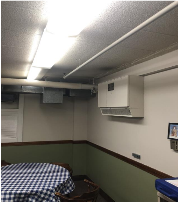
Fig. 12: Existing fan coil unit.
